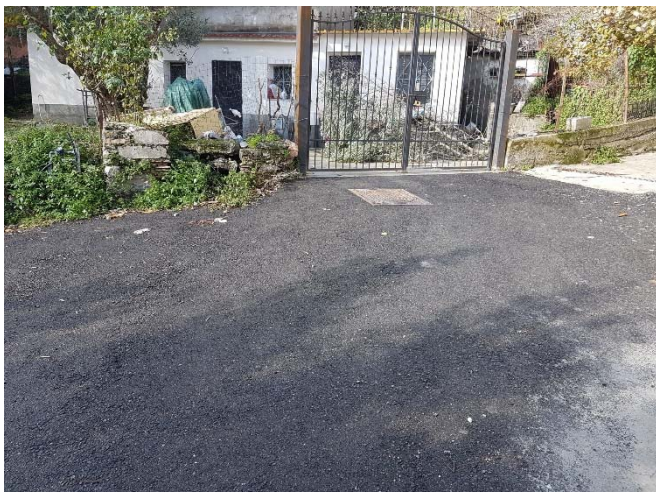
Figura 15 - Pozzetto fognatura a gravità esistente a nuovo S2
