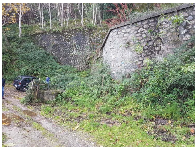
Figura 11 - Ubicazione stazione di sollevamento S3 (foto 2)
