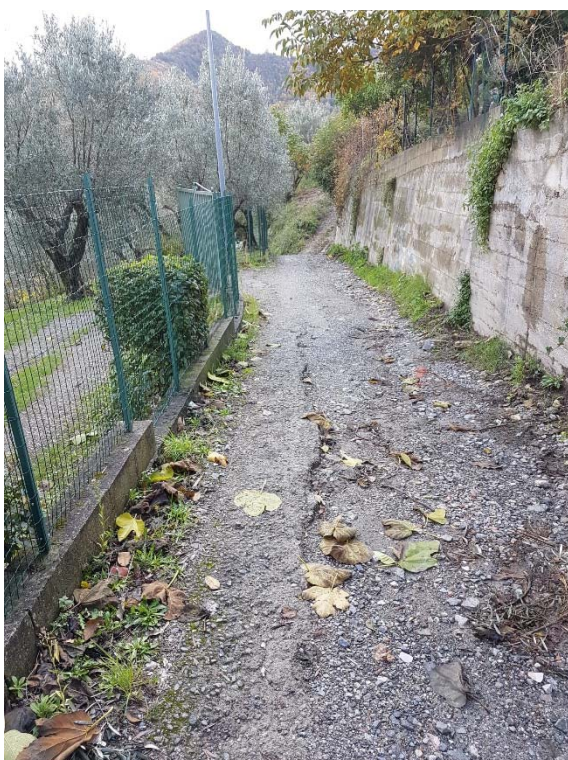
Figura 21 - Strada nuova fognatura premente da SI
