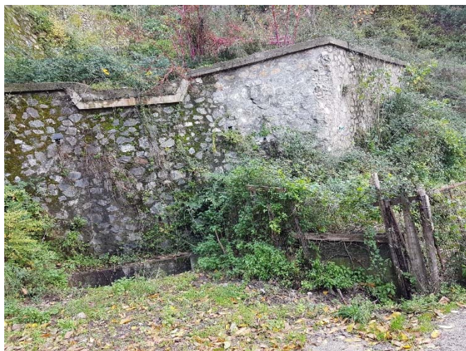
Figura 10 - Ubicazione stazione di sollevamento S3 (foto 1)
