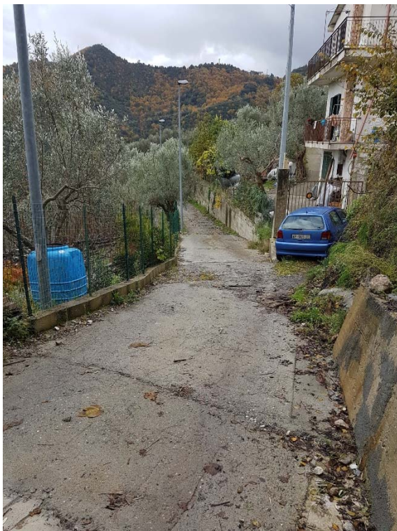
Figura 20 - Strada nuova fognatura premente da SI
