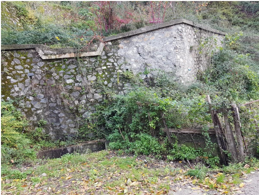
Figura 9 - Area dove verrà realizzata una nuova stazione di sollevamento
