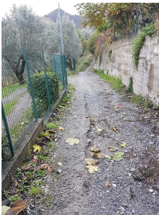
Figura 12 - Area dove verrà ubicata una nuova stazione di sollevamento
